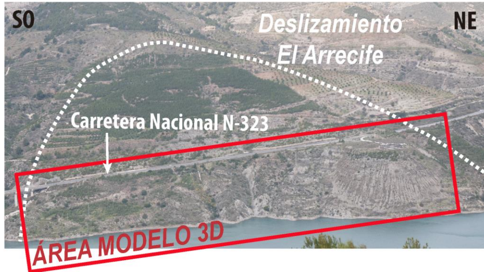
Figura 9. Fotografía del deslizamiento de El Arrecife donde se indica el área seleccionada para la generación del modelo 3D mediante vuelos de Dron.
